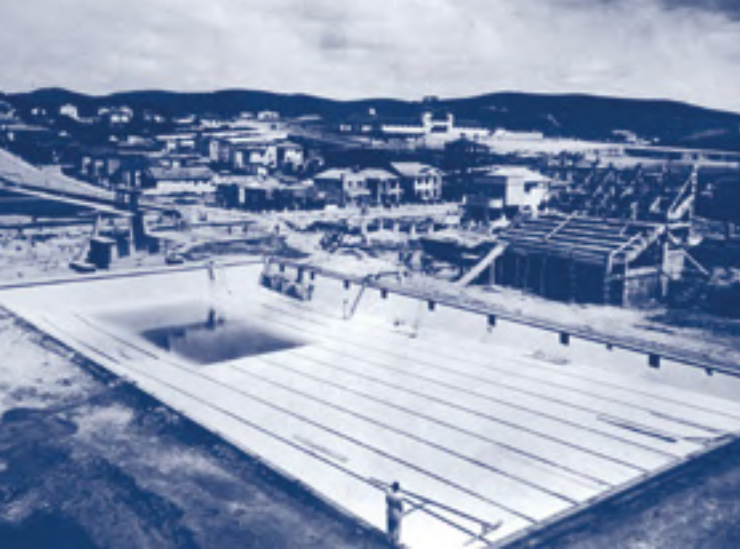
▲ Obras de construção do Parque Santo Antônio, em 1937. Foto: Câncio de Oliveira
