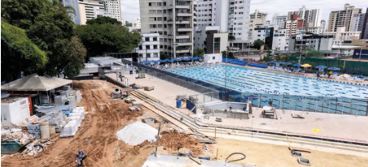
Obra de construção do Plano Diretor do Minas II , em novembro de 2025. Foto: Hedgard Moraes
