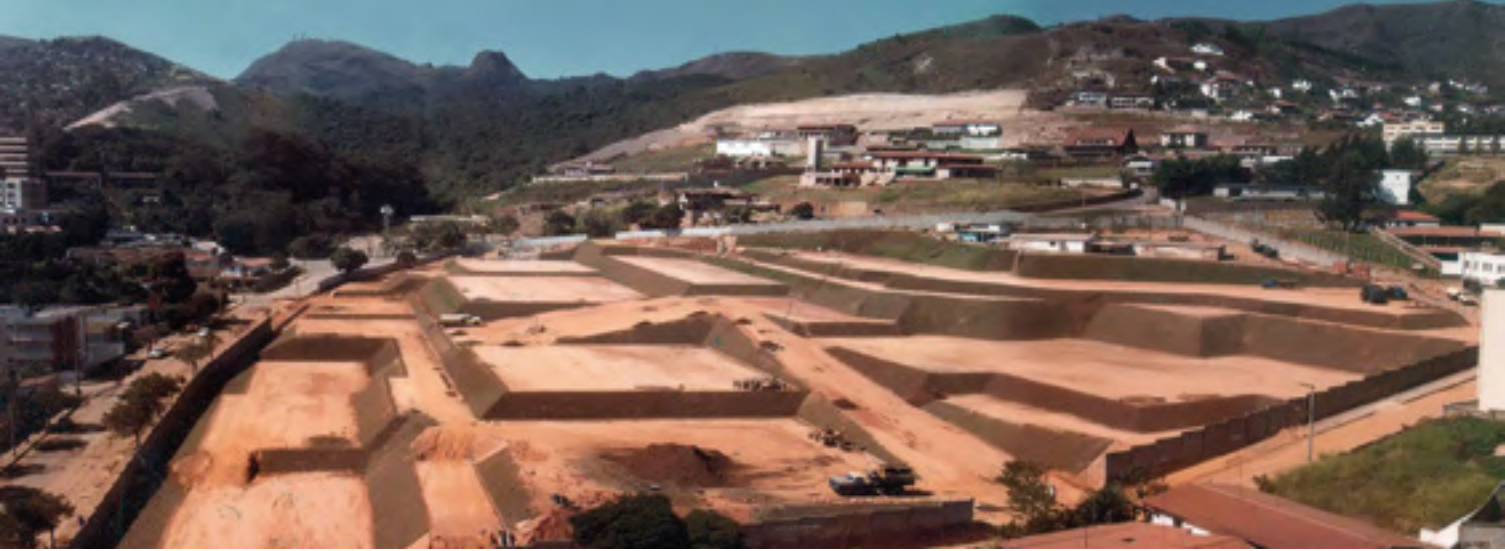
◀ Obras de construção do Minas II, em 1984. Foto: Acervo do Centro de Memória Minas Tênis Clube
