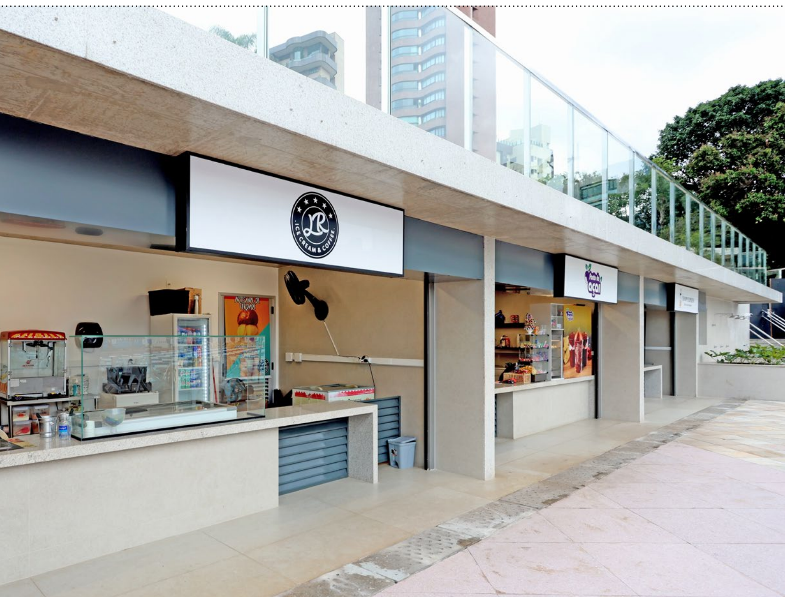
Novos quiosques já estão em funcionamento ao redor da piscina semiolímpica
