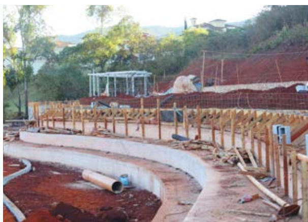
4.510 m 2 de quadras de areia e arquibancadas em construção no Náutico
