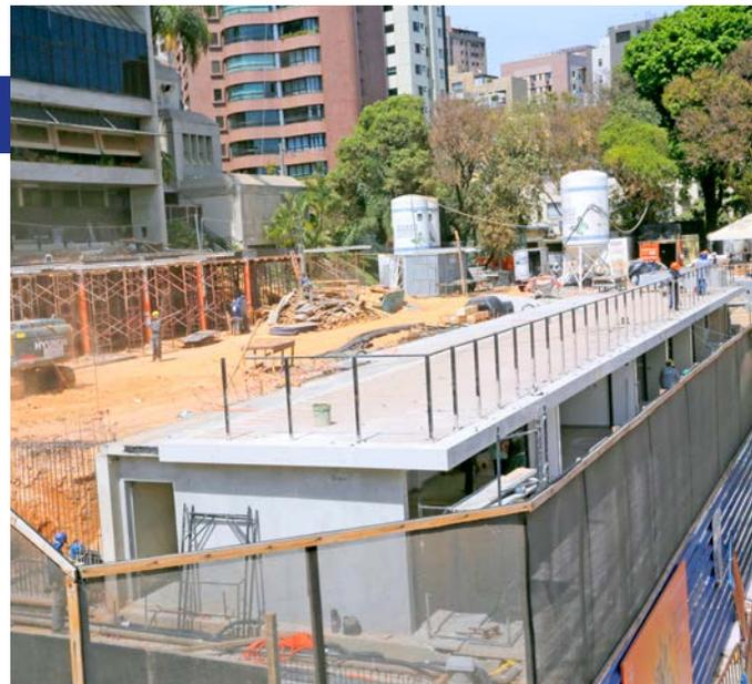
Instalação de pisos e guarda-corpos marca a fase final da execução do deck panorâmico, acima dos quiosques
