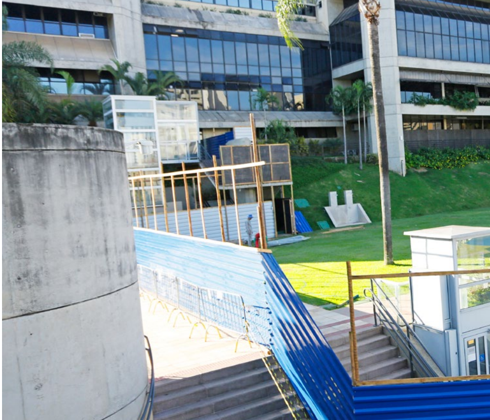
Gramado do Minas II é interditado com tapume para obra do Plano Diretor
